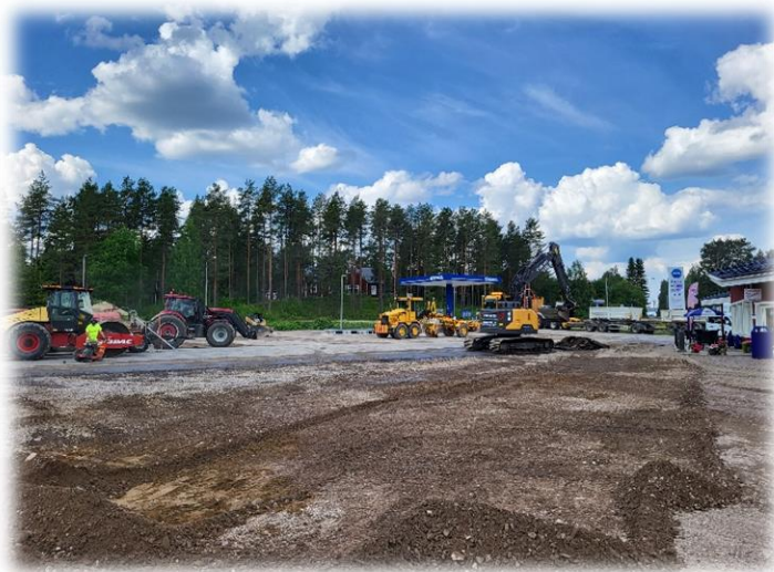
Kuvassa uusi jakeluasema on valmistumassa ja liikekeskuksen pihan asfaltointi käynnissä.
