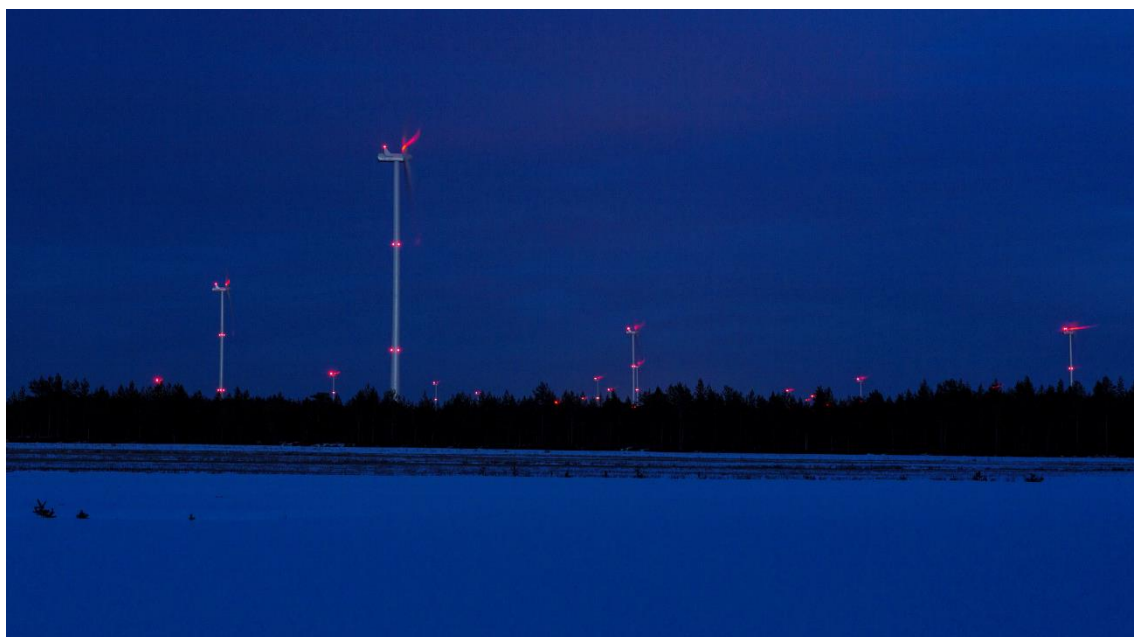
Kuva 70. Kiinteät punaiset lentoestevalot pimeällä. (Kuva: Ville Suorsa/FCG)
