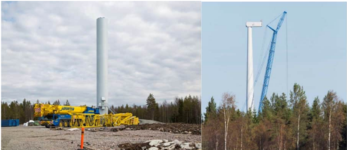
Kuva 95. Kuvapari. Tuulivoimalan kokoamista (Kuvat: FCG).
