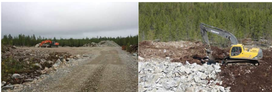
Kuva 92. Kuvapari. Tuulivoimapuiston rakentaminen alkaa huoltoteiden ja pystytysalueiden rakentamisella (Kuvat: FCG).
