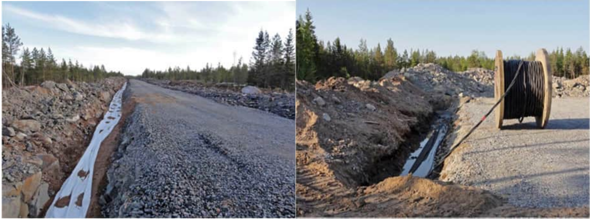
Kuva 93. Kuvapari. Maakaapelit upotetaan huoltoteiden yhteyteen (Kuvat: FCG).
