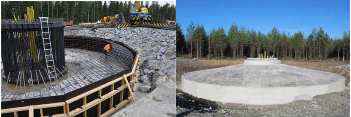
Kuva 94. Kuvapari. Tuulivoimalan perustusten rakentamista (Kuvat: FCG).
