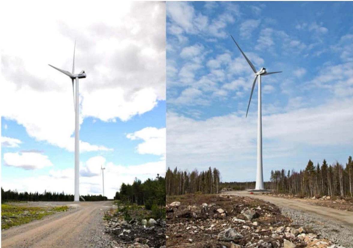
Kuva 83. Kuvapari. Vasemmalla on esimerkki teräslieriötornista ja oikealla hybriditornista (Kuvat: FCG).
