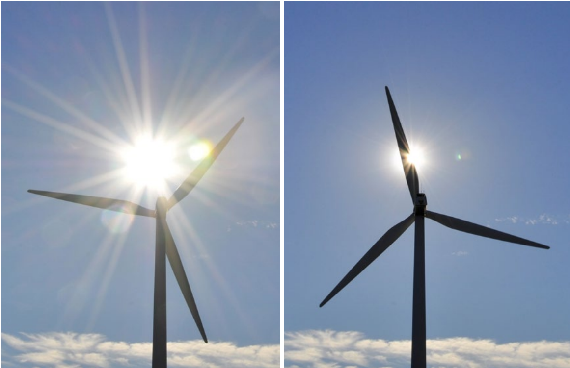
Kuvapari 59. Tuulivoimaloiden lavat aiheuttavat pyöriessään vilkkumista ja varjon välkkymistä aurinkoisella säällä. © FCG
